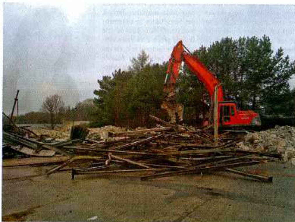
Anfang des Jahres rollten die ersten Baufahrzeuge über das ehemalige Polizeischulgelände in Basdorf. Bis März 2013 sollen 15 bis 20 Gebäude abgerissen werden. Foto: Gemeinde Wandlitz
