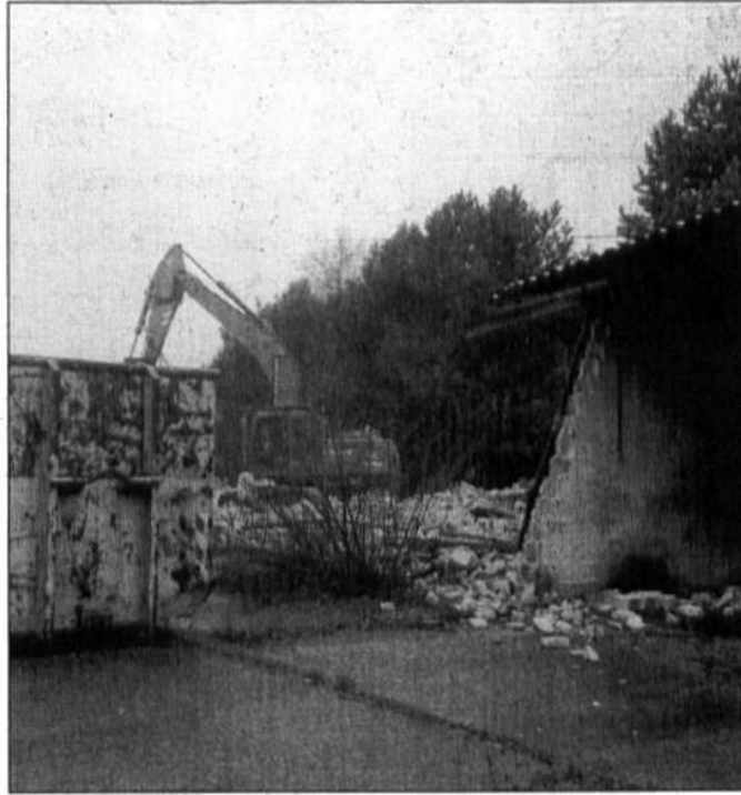
Entfernt: Die alten Garagen auf dem einstigen Polizeischulgelände werden hier noch abgerissen – inzwischen sind alle weg. Foto: Gemeinde
